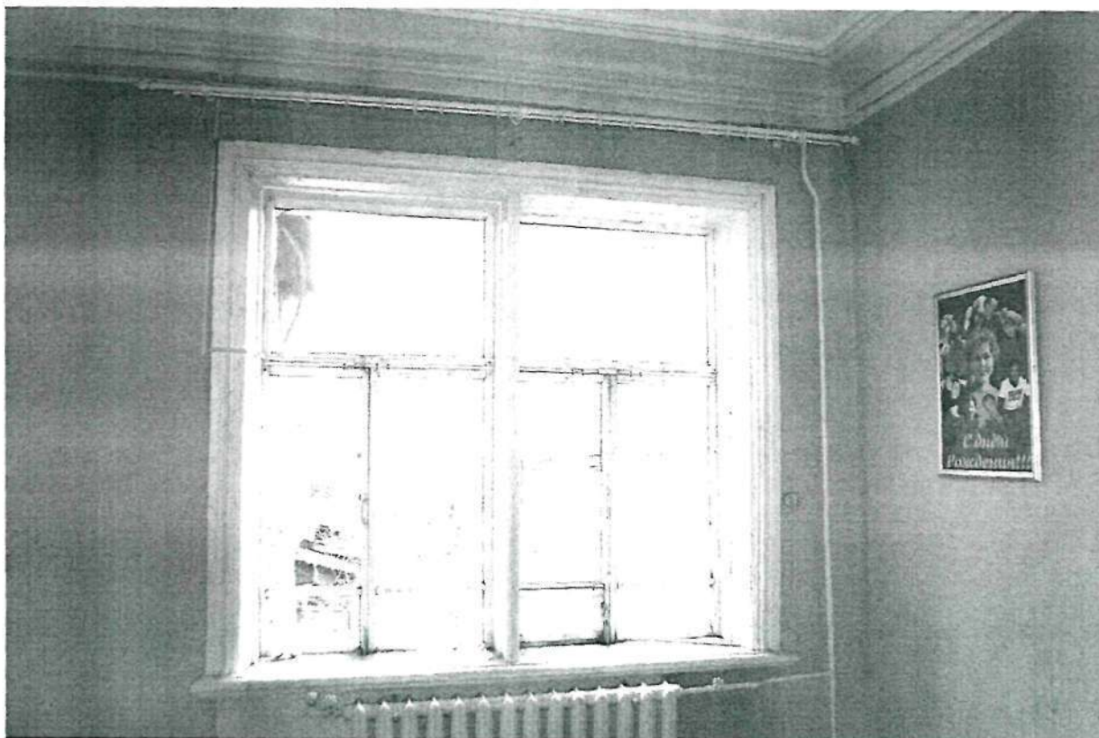
Фото 18. Интерьер второго этажа; потолочно-стеновые тяги в комнате, соответствующей третьей оконной оси западного фасада объекта (в уровне второго этажа)
