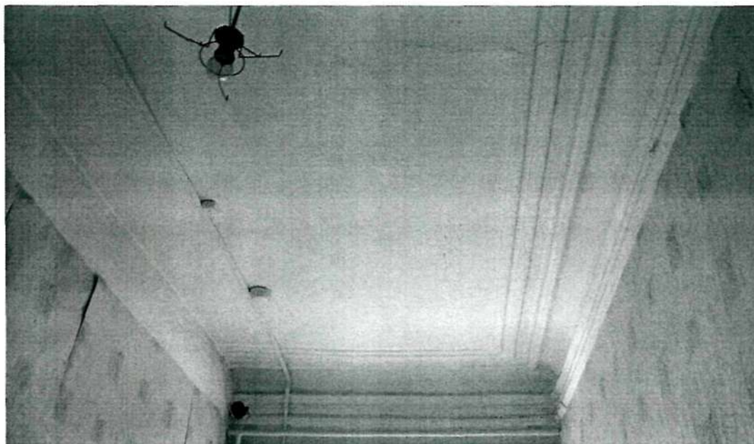
Фото15. Интерьер второго этажа; потолочно-стеновые тяги в комнате, соответствующей четвертой оконной оси восточного фасада объекта (в уровне второго этажа)
