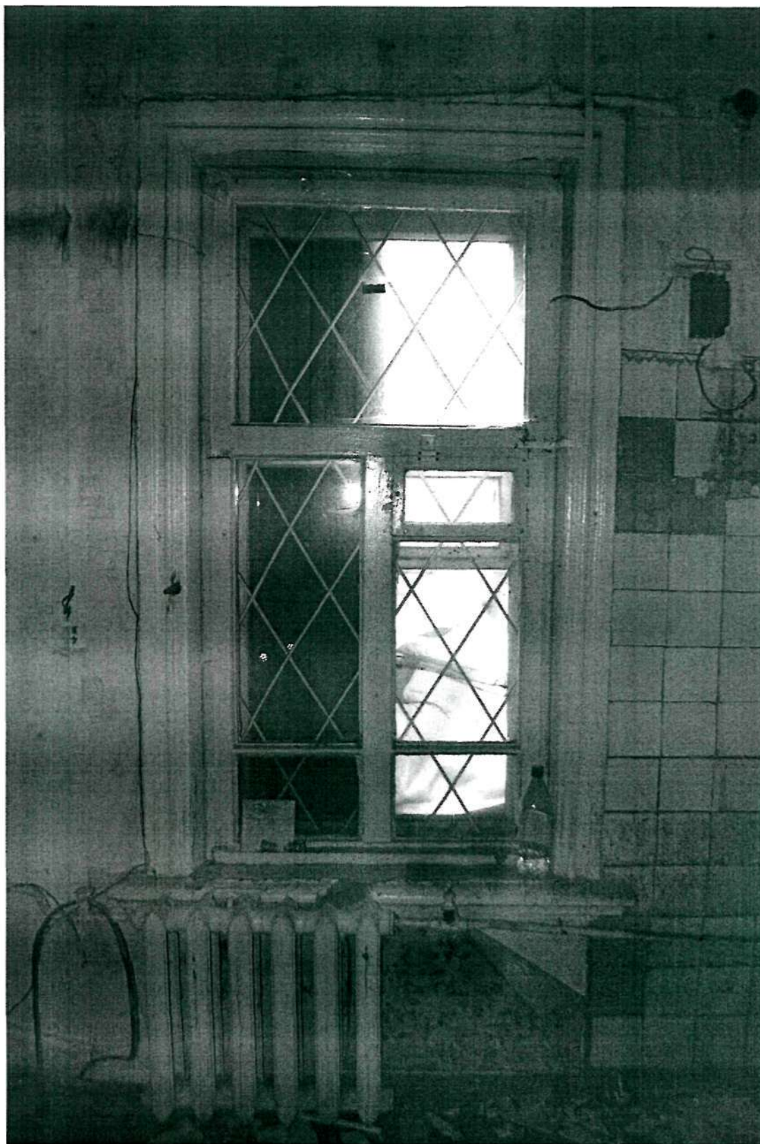
Фото 12. Интерьер первого этажа; наличники оконного проема в комнате, соответствующей первой оконной оси северного фасада основного объема объекта (в уровне первого этажа); аналогичные наличники сохранились на большей части оконных проемов в помещениях объекта
