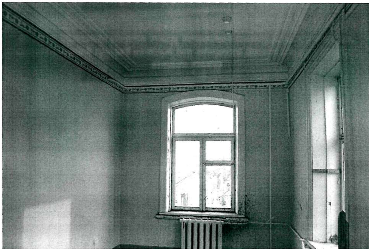
Фото 19. Интерьер второго этажа; потолочно-стеновые тяги в комнате, соответствующей первой оконной оси восточного фасада объекта (в уровне второго этажа)
