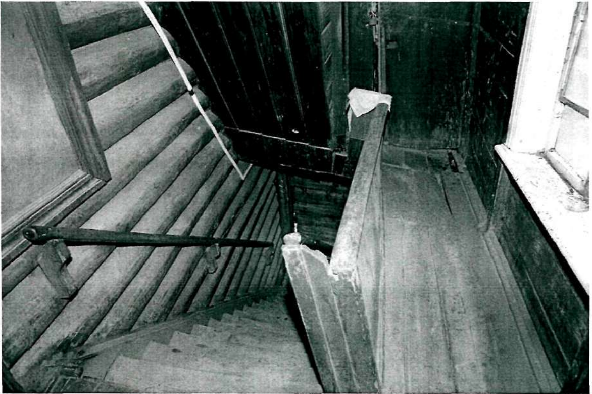
Фото 9. Лестница в западном крыле дома (фрагмент)
