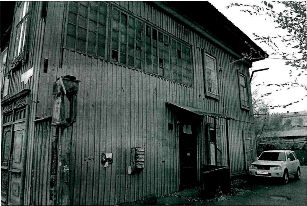
Фото 3. Северный фасад (вид с северо-востока)
