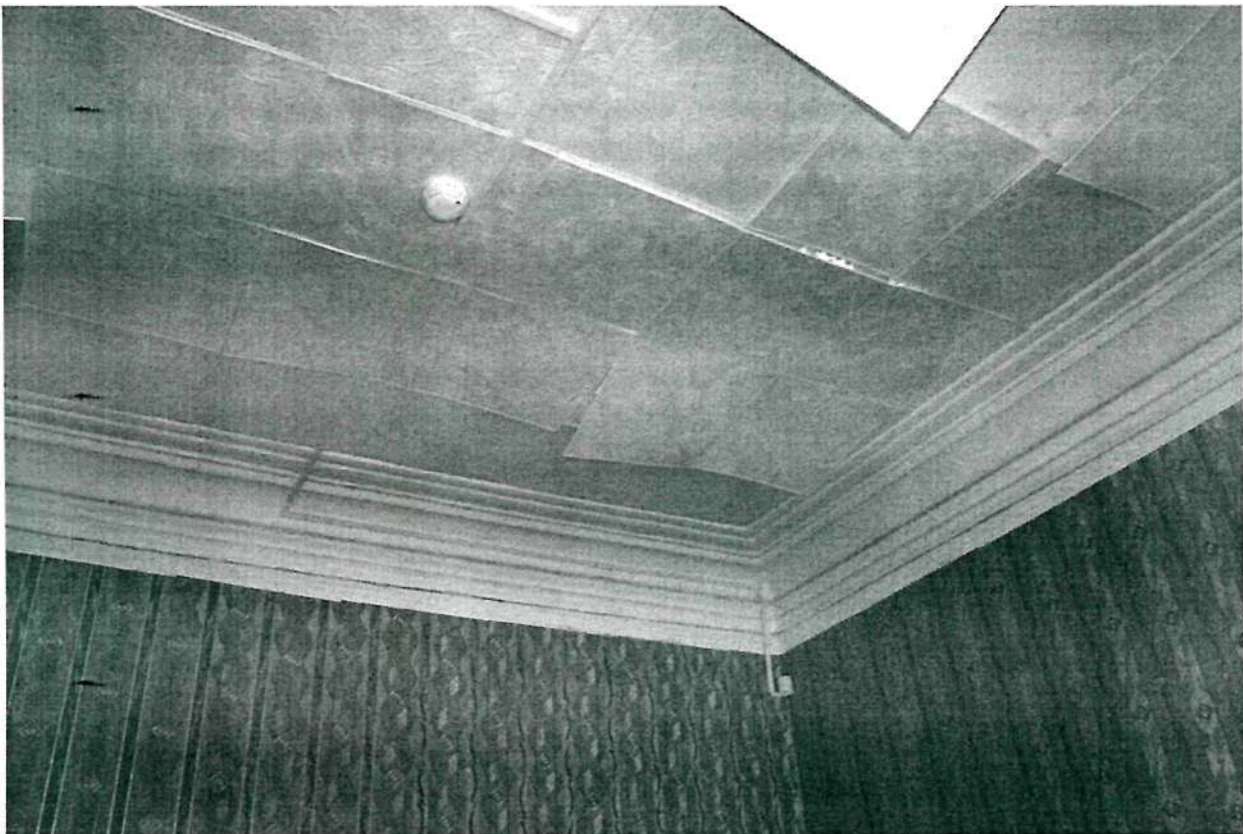
Фото 14. Интерьер второго этажа; потолочно-стеновые тяги в комнате, соответствующей пятой и шестой оконным осям восточного фасада объекта (в уровне второго этажа)
