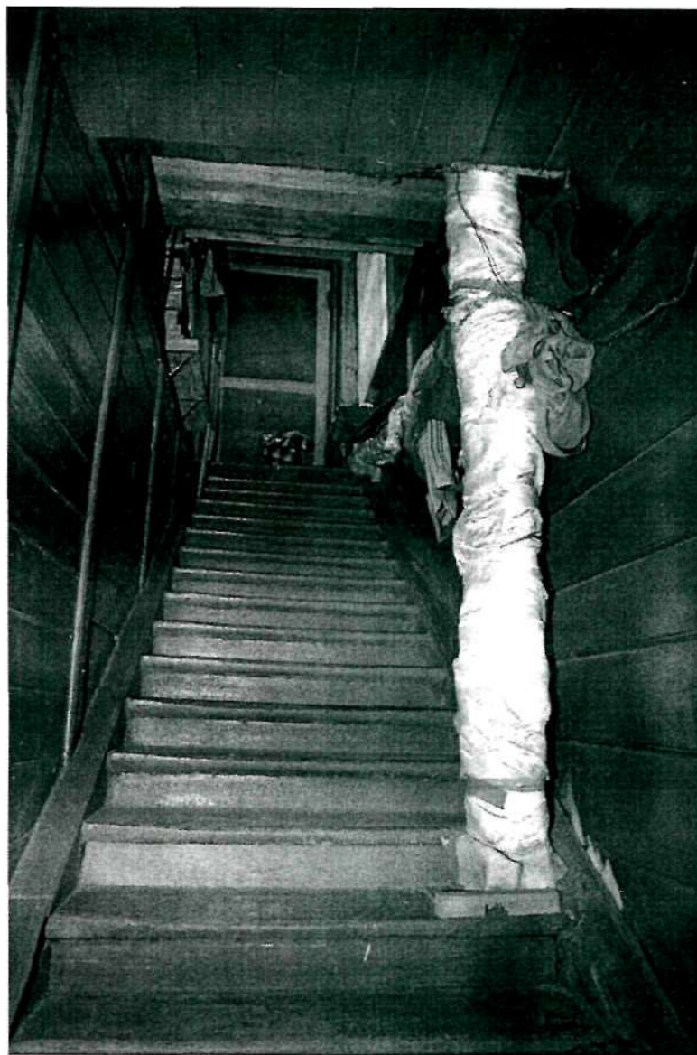
Фото 30. Интерьер первого этажа; парадная лестница
