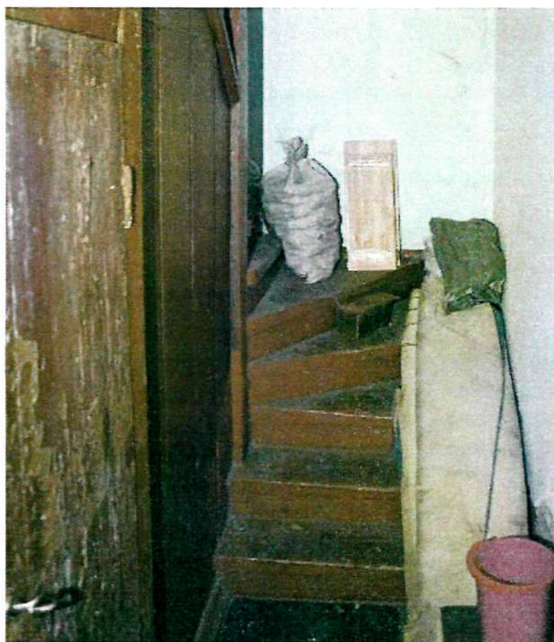
Фото 17. Интерьер цокольного этажа; забежная лестница, ведущая в западную часть первого этажа
