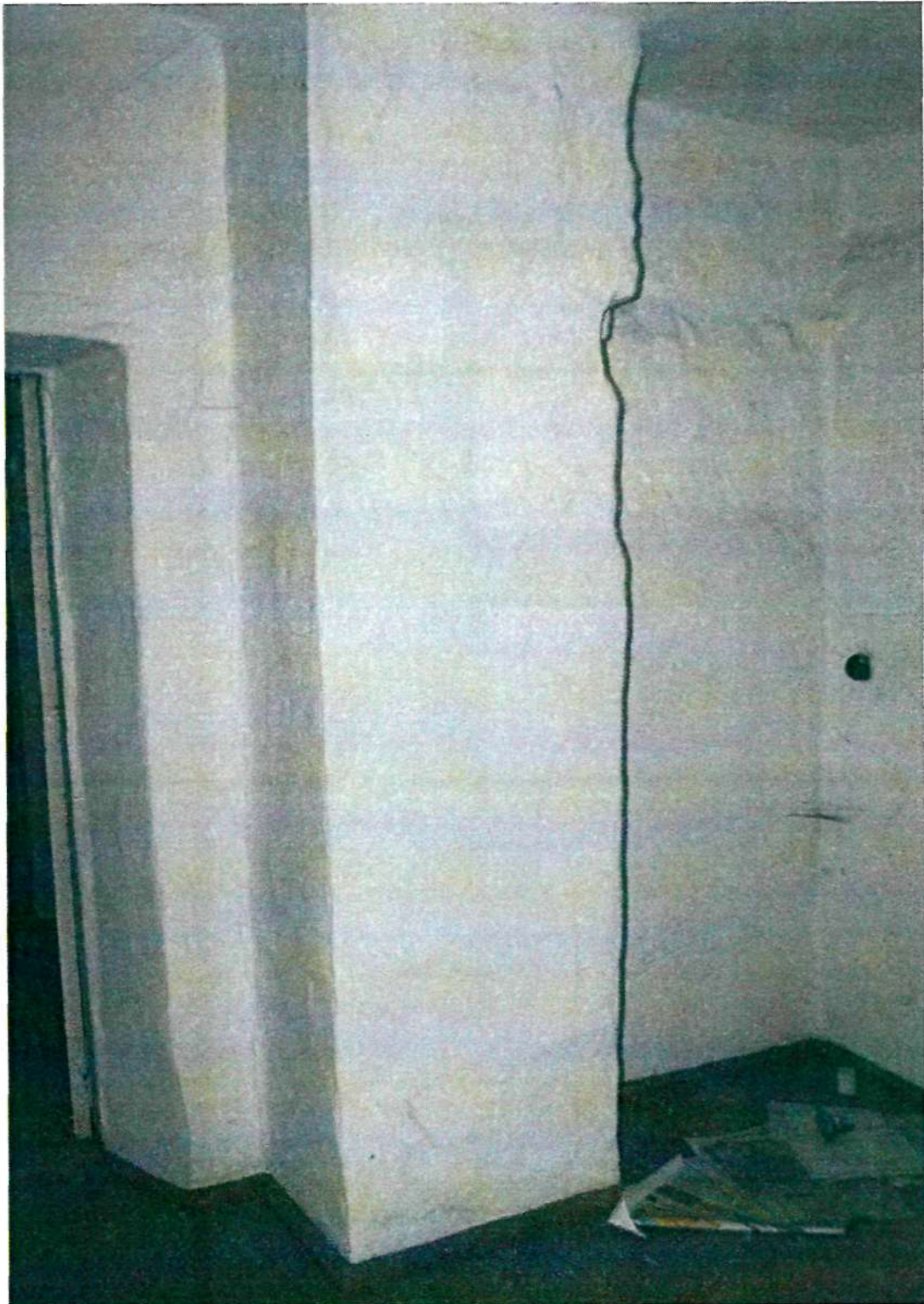
Фото 11. Интерьер цокольного этажа; печной блок, расположенный на плане в западной части цокольного этажа (вид 2)
