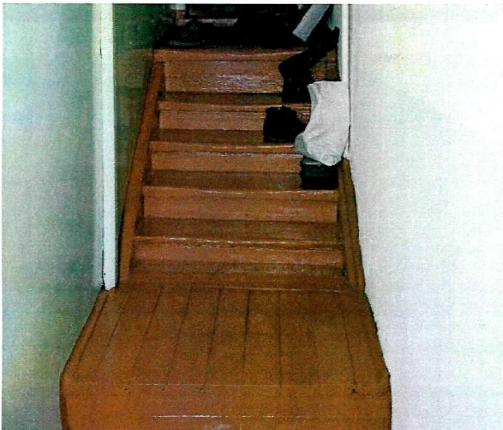
Фото 4. Интерьер; лестница, расположенная при входе в восточную часть цокольного этажа
