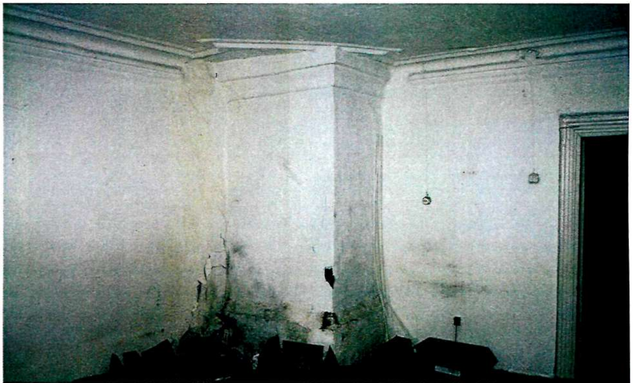
Фото 6. Интерьер цокольного этажа; печной блок, расположенный на плане в восточной части цокольного этажа (вид 1)
