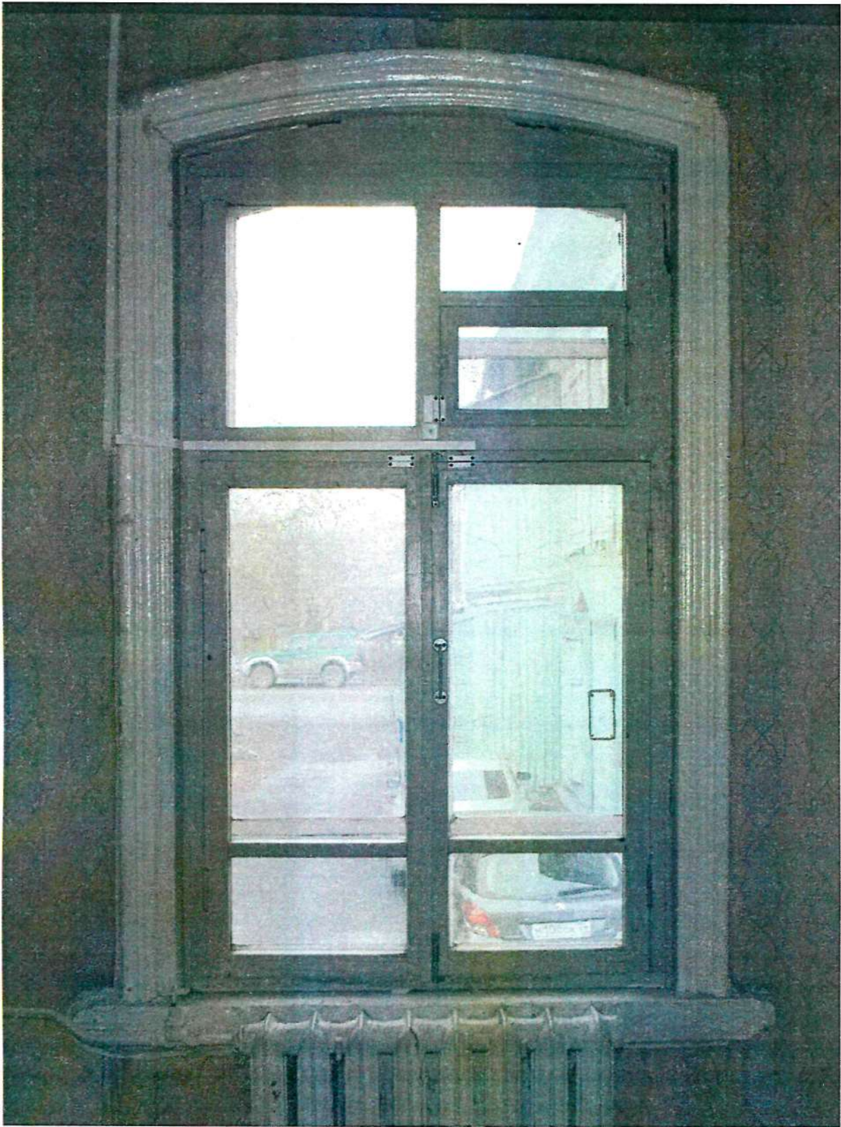
Фото 12. Профилированные наличники одного из оконных проемов первого этажа
