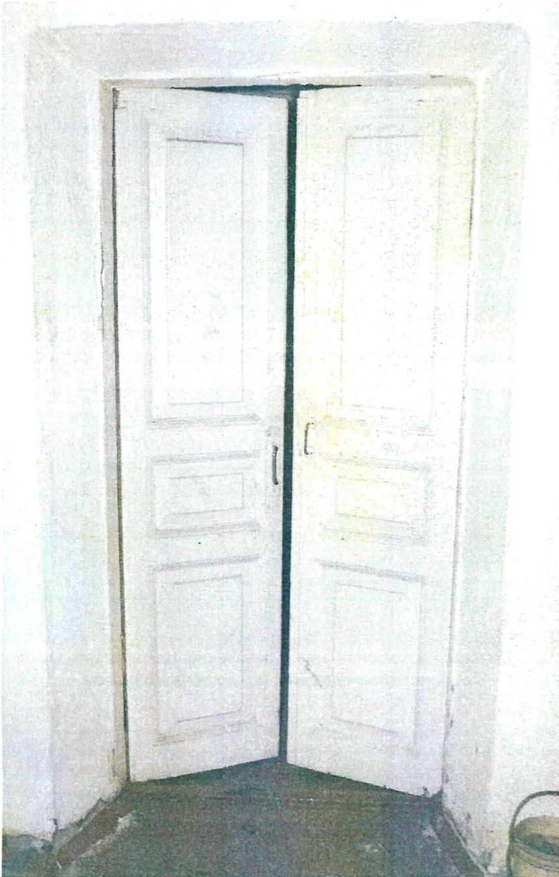
Фото 10. Интерьер цокольного этажа; филенчатая дверь южного межкомнатного дверного проема поперечной несущей стены
