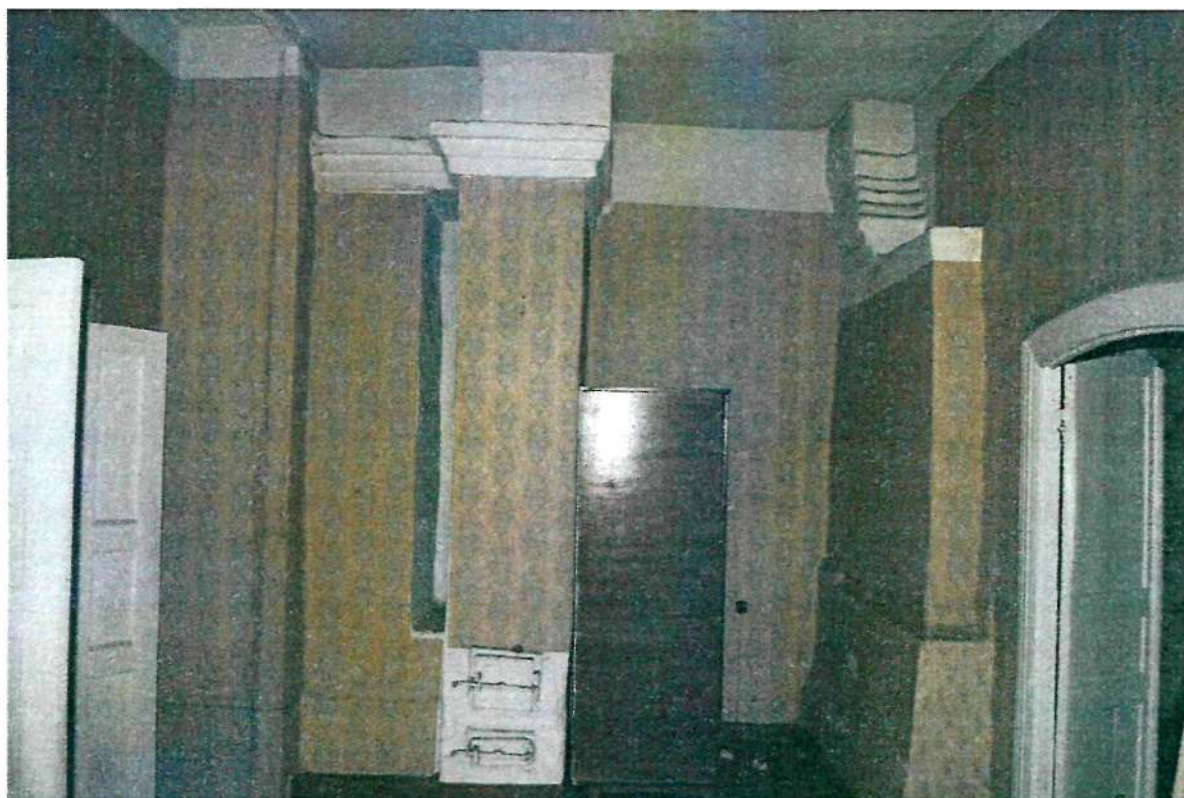
Фото 16. Интерьер первого этажа; печной блок, расположенный на плане в восточной части первого этажа (вид 2)
